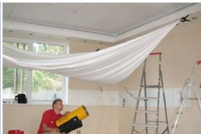
Фото 10. Нагрев ПВХ полотна
