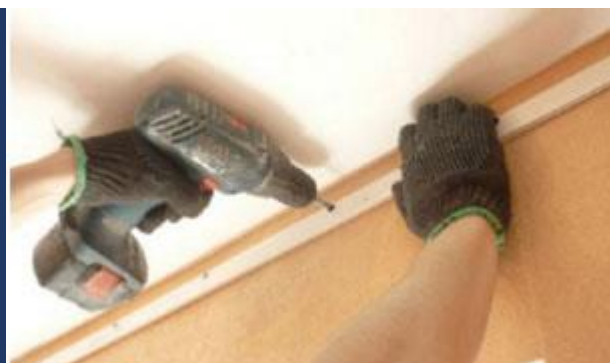
Фото 9. Установка профиля (багета)
